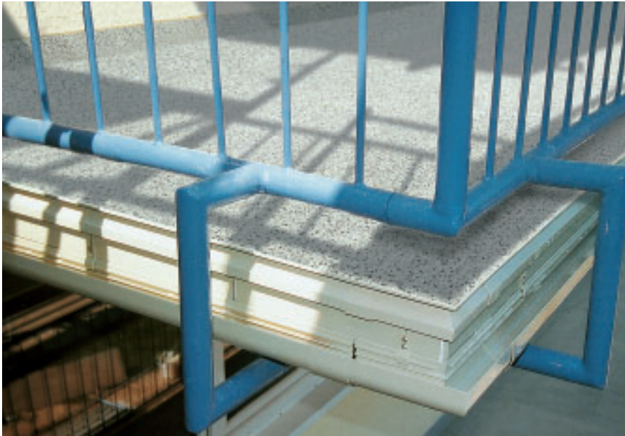
WatecFin-Profil servaviimistlus, mahavoolav kondenseerunud vesi juhitakse ära renni abil.
