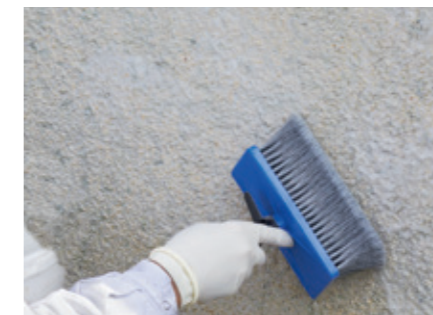
Töötle fassaad biotsiidlahusega Capatox ning lase pinnal korralikult kuivada.
